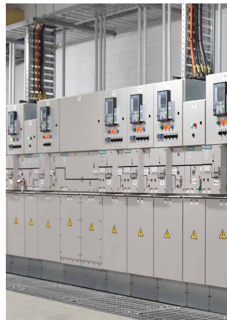
Above: Barangaroo 33kV Siemens switchgear
